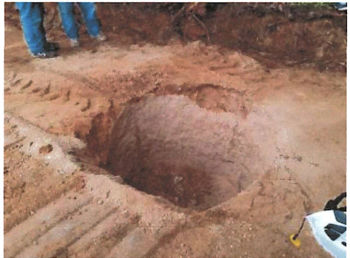
Fotografías 8 y 9. Vista del área donde se realizan trabajos de compactación y se identificó una oquedad, atribuida a un posible pozo de visita.
