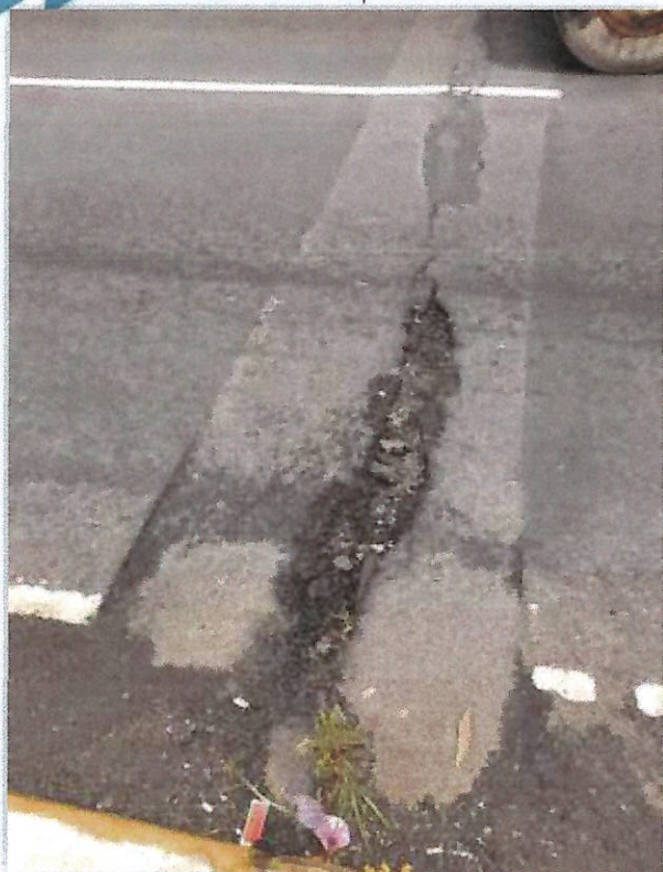
Fotografías 10 y 11. Vista de las condiciones de desgaste que evidencia la carpeta asfáltica y juntas en los tramos del paso a desnivel Ing. Enrique Tejada Wyld.
