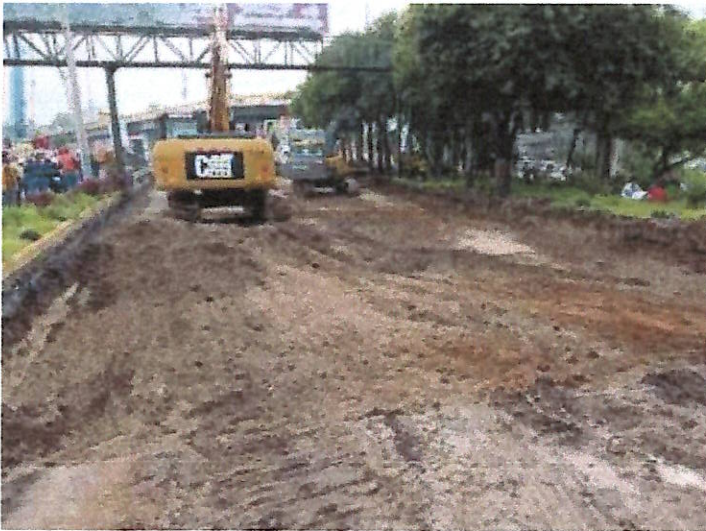
Fotografías 8 y 9. Vista del área donde se realizan trabajos de compactación y se identificó una oquedad, atribuida a un posible pozo de visita.
