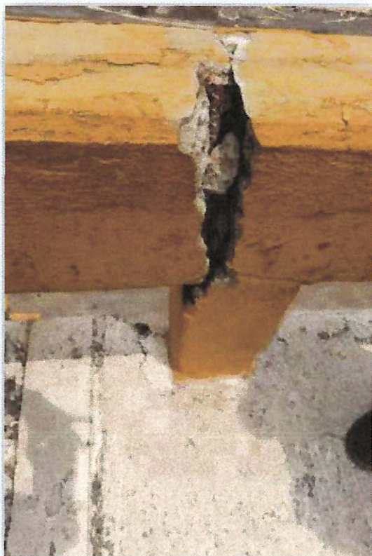
Fotografías 10 y 11. Vista de las condiciones de desgaste que evidencia la carpeta asfáltica y juntas en los tramos del paso a desnivel Ing. Enrique Tejada Wyld.
