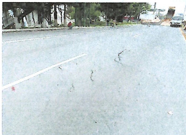
Fotografías 1 y 2. Vista de grietas en la pista con dirección norte de la CA-09, Ruta al Pacífico.
