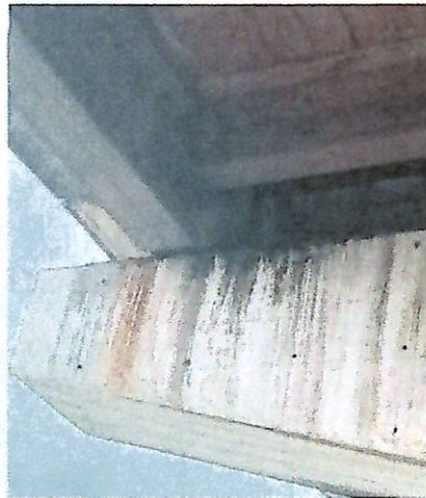
Fotografías 18. Vista de uno de los cabezales del puente donde se apoyan vigas longitudinales
