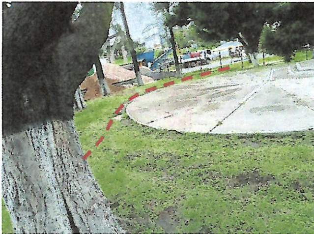
Fotografía 7. Vista del área verde donde continua la grieta identificada.
