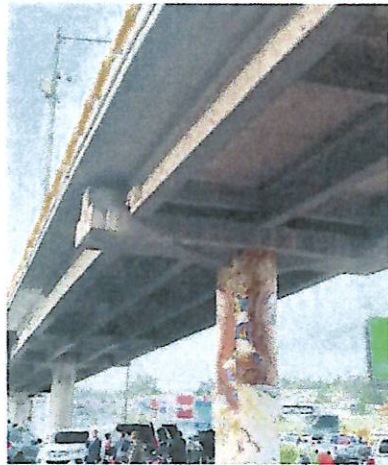
Fotografías 17. Vista de uno de los pilares del puente
