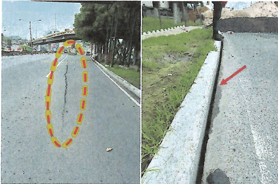
Fotografías 3 y 4. Vista de grietas y deformación en la estructura del pavimento flexible en la CA-09 Sur, Ruta al Pacífico.
