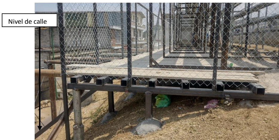
Figura 7: Conformación de plataforma para emplazamiento de graderío metálico.
