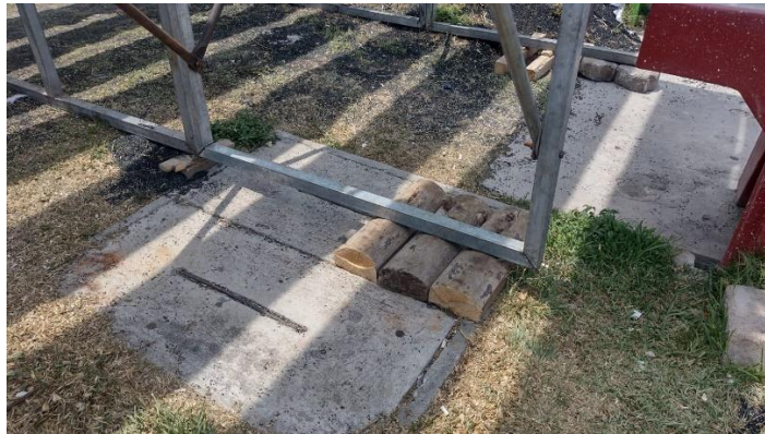
Figura 4: Visualización de cuñas de madera, para nivelación de las estructuras, graderíos metálicos.
