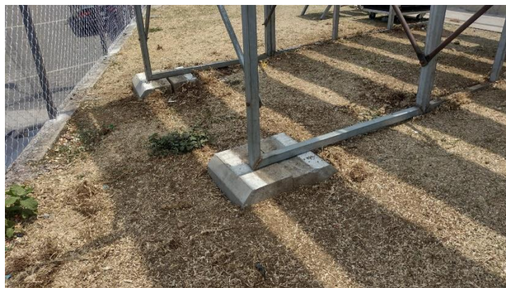
Figura 5: Visualización de cuñas de madera, para nivelación de las estructuras, graderíos metálicos.
