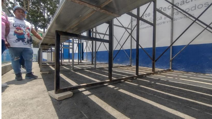
Figura 3: Visualización de cuñas de hormigón, para nivelación de las estructuras, graderíos metálicos.
