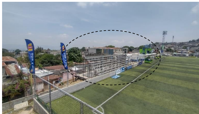
Figura 2: Visualización (círculo punteado) graderío de estructura metálica.
